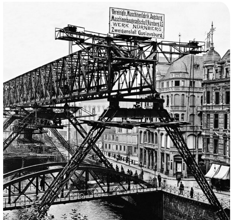
Bau des Schwebobahngerüsts um 1900 in Elberfeld
