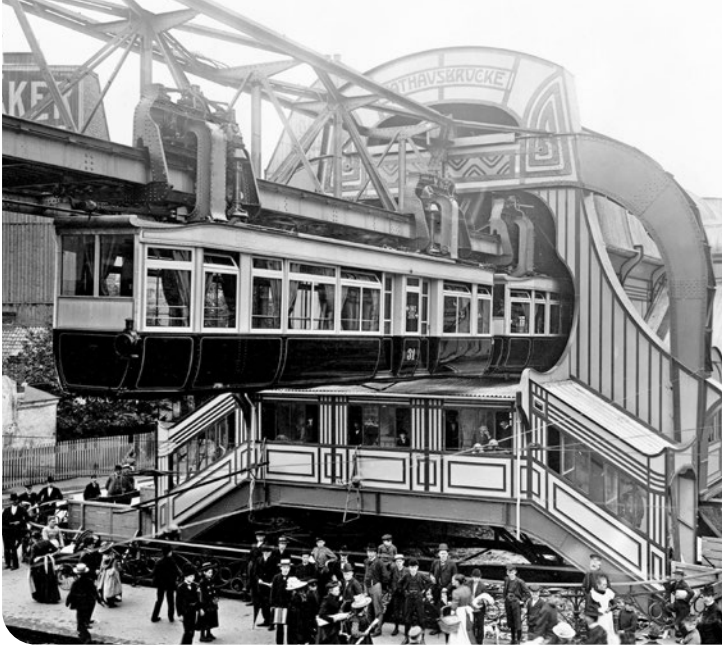
Station Rathausbrücke – heute Alter Markt
