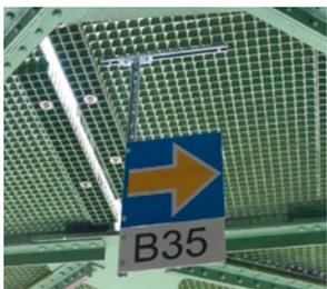
Signale gemäß Führerstands-signalisierung ETCS-Level 2. Dem Fahrpersonal werden benötigte Daten zum Streckenzustand auf dem Tachometer angezeigt.
